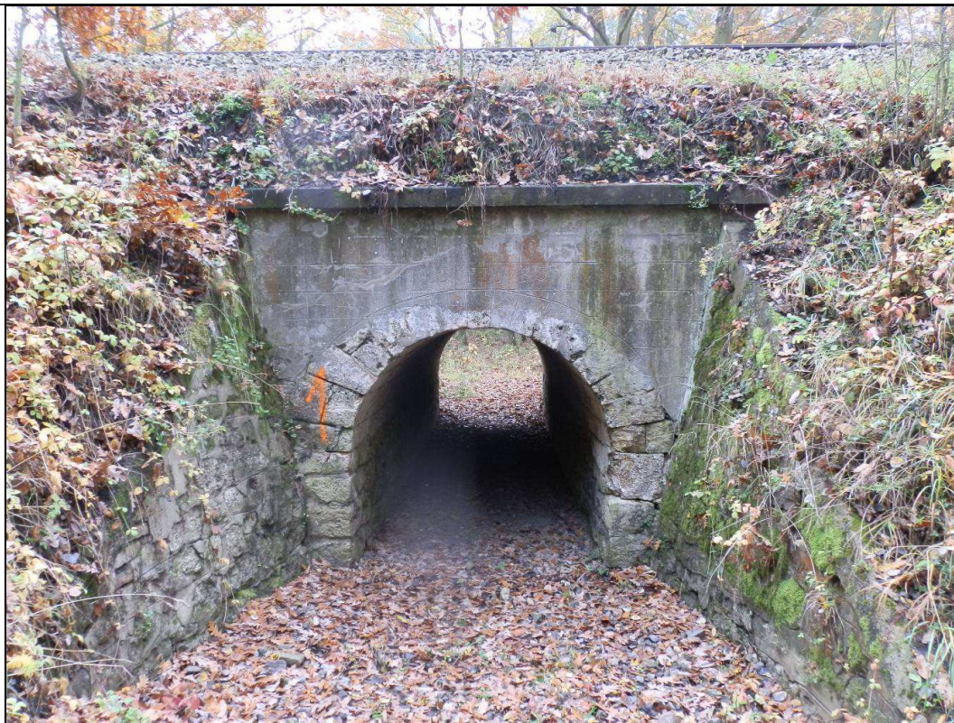
Obr. č. 4 - pravé čelo objektu, spárování zdiva klenby je většinou vypadané
