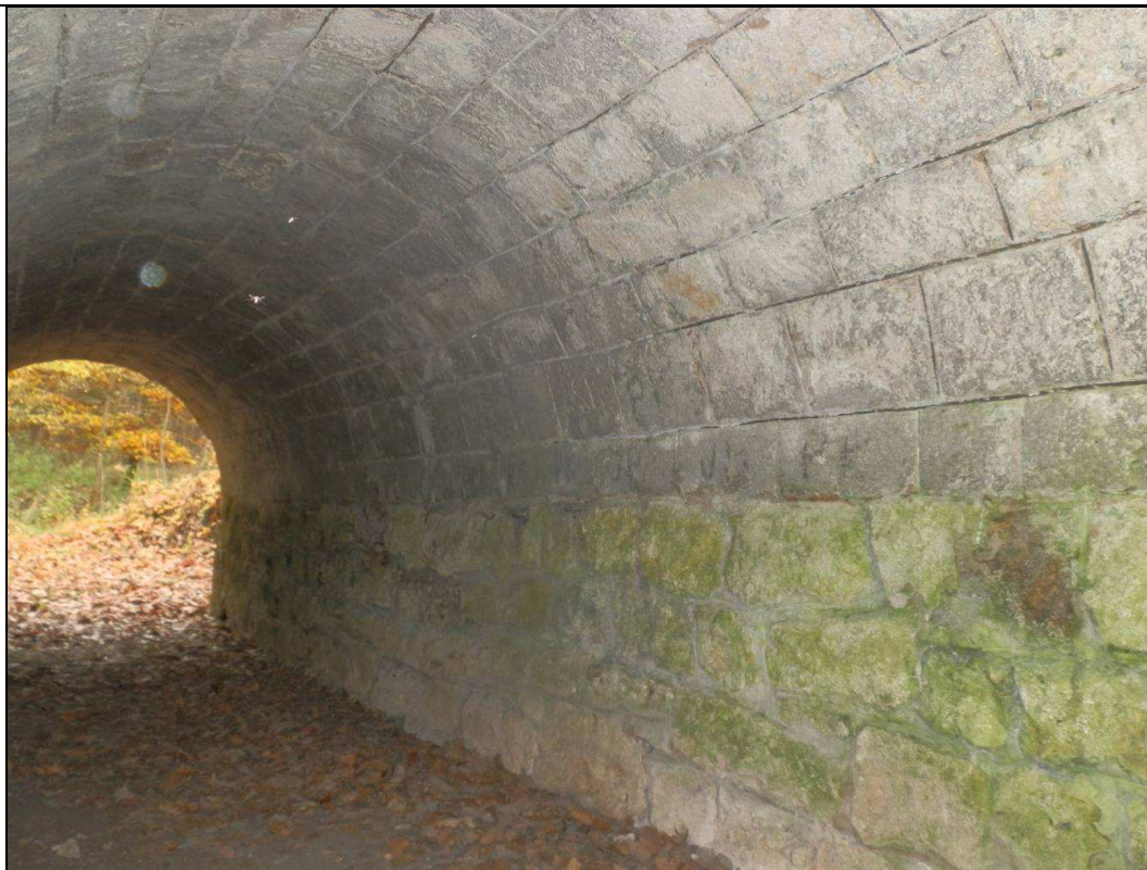
Obr. č. 6 - opěra Břeclav, povrch opěry a klenby je bez větších poruch
