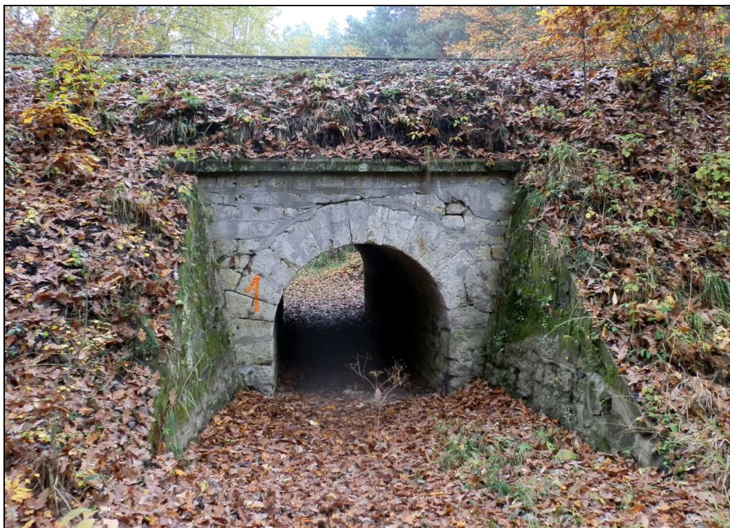
Obr. č. 3 - levé čelo objektu, spárování zdiva je místy vypadané
