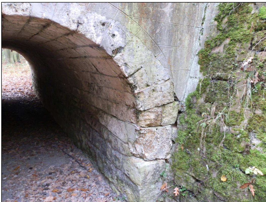
Obr. č. 7 - pravé čelo, detail vypadajícího spárování
