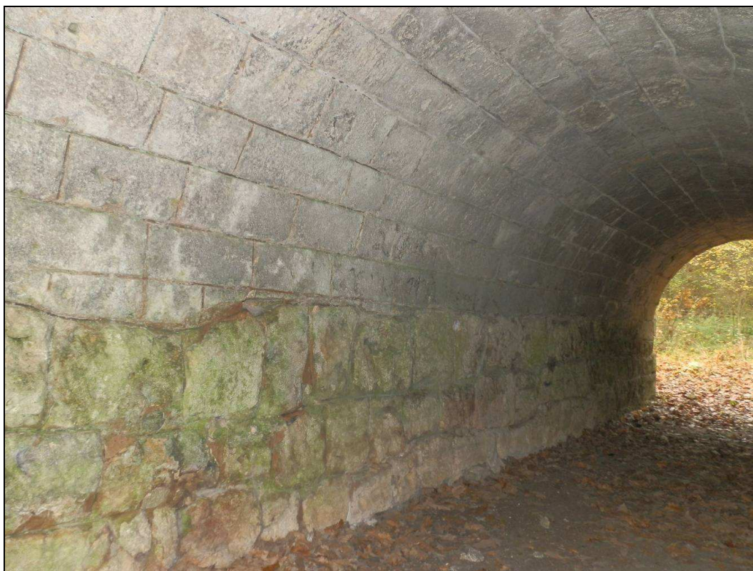
Obr. č. 5 - opěra Znojmo, povrch opěry a klenby je bez větších poruch
